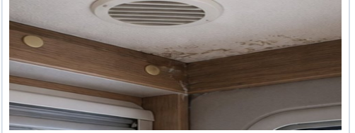
K05 - Havalandırma, yoğuşma izi ve koku kontrolü
