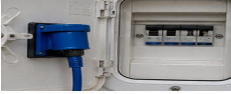
G01 - 230V dış giriş, kaçak akım ve sigorta paneli
