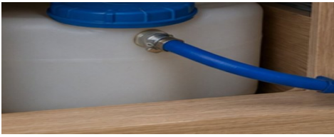
H01 - Temiz su deposu, dolum ağız ve bağlantı sızdırmazlığı
